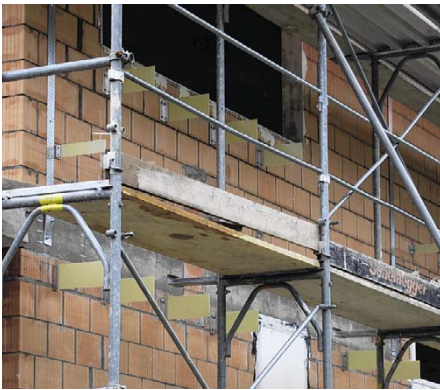
Die Befestigungsschwerter der Weltneuheit Phoenix Facade (Wärmebrückenfrei!)
