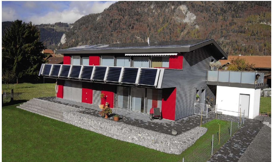
Südfassade mit Sonnenkollektoren (22,5 m 2 ) und Photovoltaik (66,4 m 2 )
