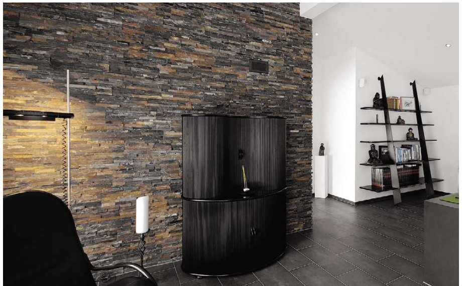
Innenwand, Passivsolarwand zum speichern der passiven Sonnenenergie.
